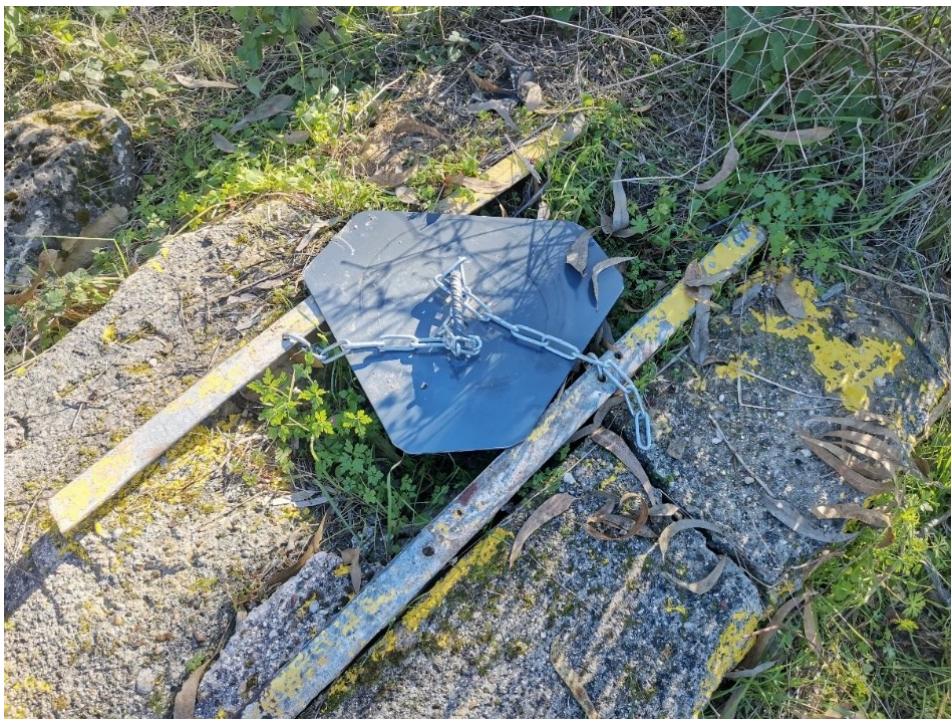
Φωτό2. Αποψη της γεώτρησης με κωδικό TE-1 όπου πραγματοποιήθηκε ο εμπλουτισμός πριν την εγκατάσταση των συνδέσεων.
