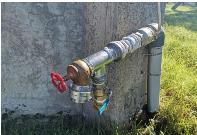
Φωτό 3. Αποψη της συνδεσμολογίας στην υφιστάμενη παροχή.
